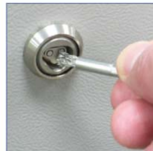
Очистка лицевой поверхности замка с помощью щетки
